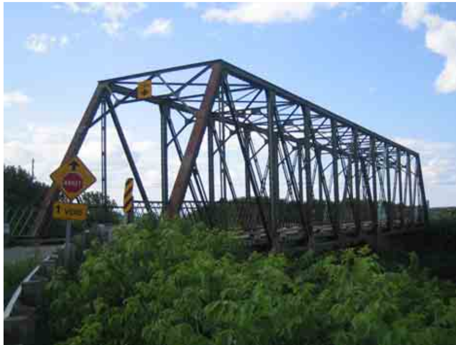
Pont métallique du rang Magenta à l'Ange-Gardien.
